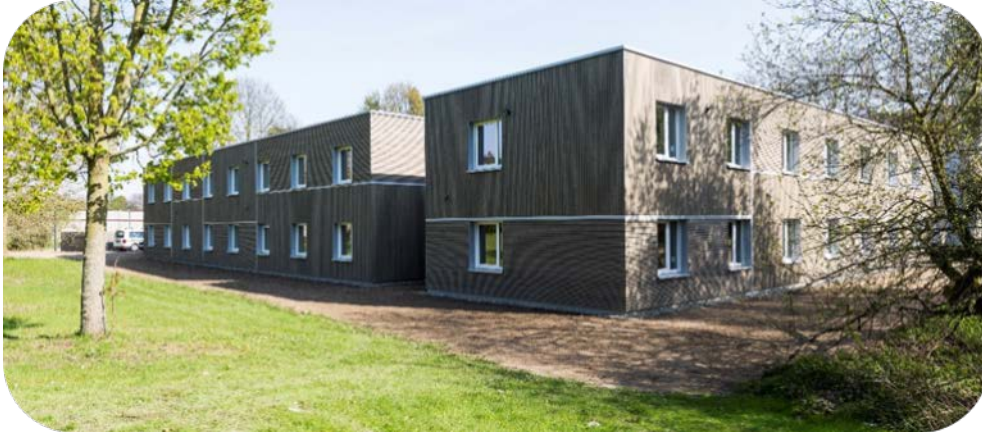
Außenansicht Wohnstandort Alte Frankfurter Straße. Foto: Stadt Braunschweig/Daniela Nielsen
