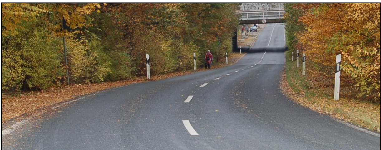
Abbildung 1: Rünigenstraße im Bereich der Unterführung der BAB A 39. Die mangelhafte Verbindung für Fußgänger und Radfahrer führt zu Gefahrensituationen.
