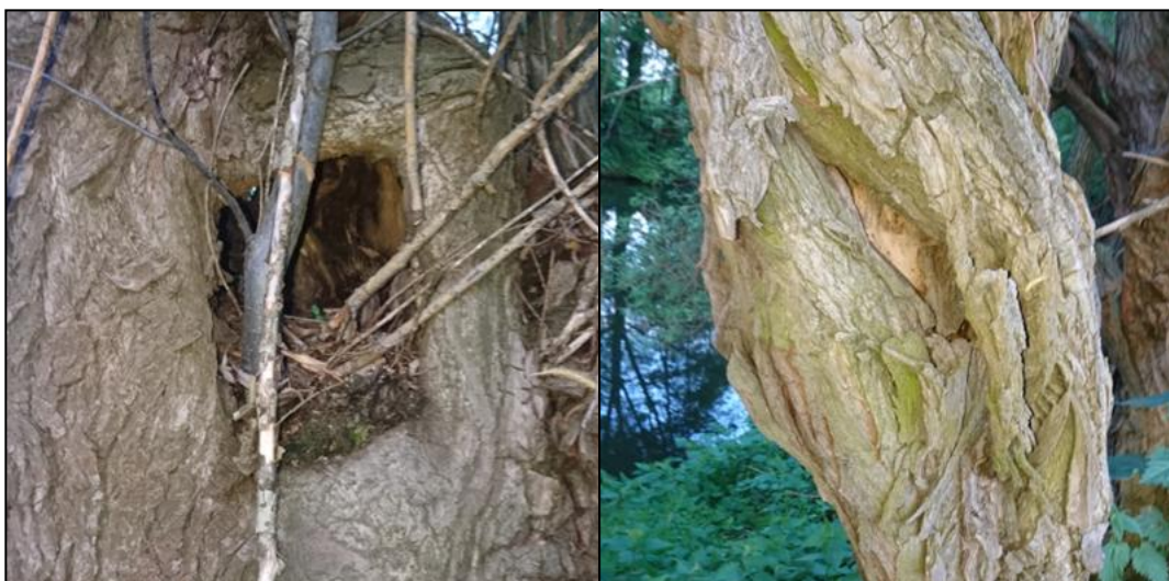
Abb. 4: Potentielle Quartiere für Fledermäuse in den Gehölzen an der Okerbrücke in Leiferde
