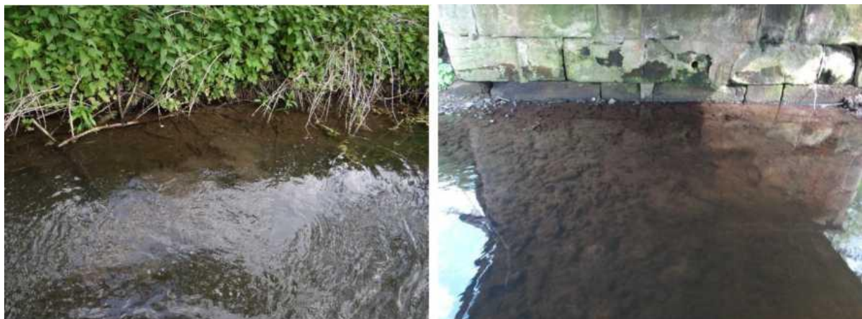
Abb. 8: Detailstruktur Ufer und Sohle im Bereich des Brückenbauwerks
