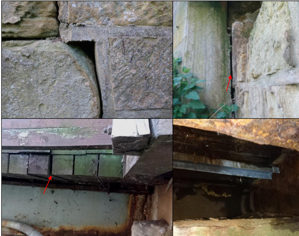
Abb. 3: Potentielle Quartiere für Fledermäuse an der Okerbrücke in Leiferde
