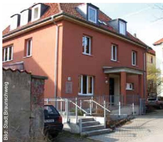
Der Madamenhof vor und nach der Sanierung
