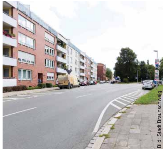
Der Knotenpunkt vor der Umgestaltung
