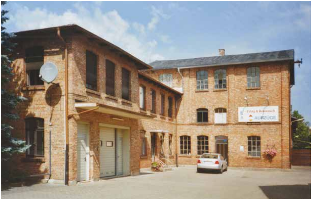
Abb. 53: Das Fabrikgebäude an der Kreuzstraße 69, 2007
