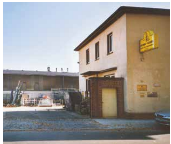
Abb. 117: Einfahrt an der Kramerstraße, 2007
