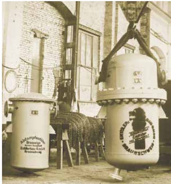
Abb. 185: Brunsviga Abdampfentöler, Patent Dempewolf
