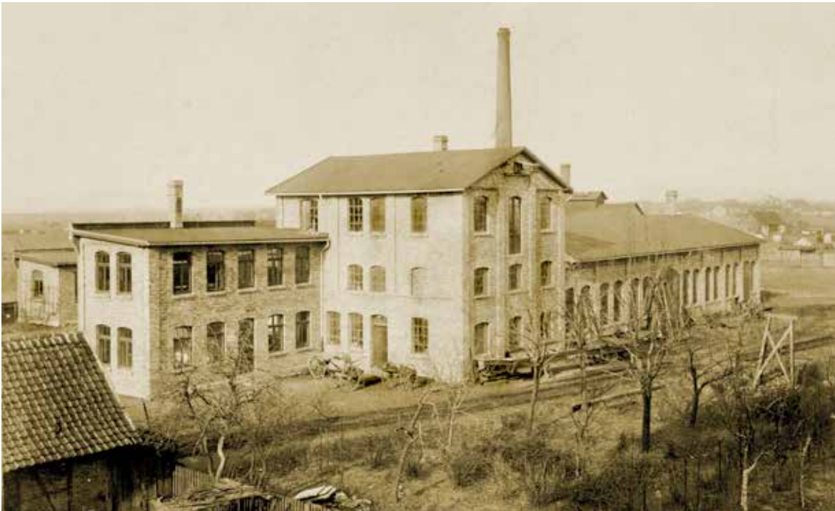
Abb. 52: Das Fabrikgebäude an der Kreuzstraße 69, 1921
