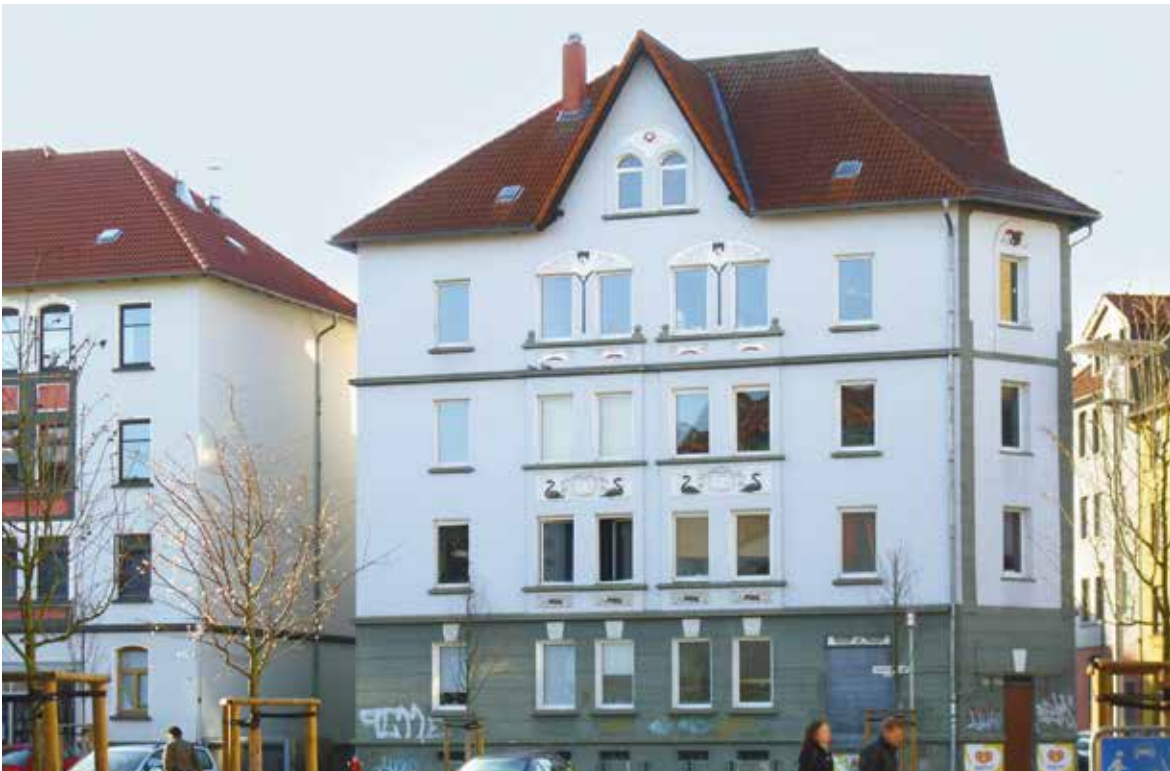
Abb. 188: Das Haus Frankfurter Straße 267 mit Produktionsstätte für Fleisch und Wurstwaren im Keller, 2010
