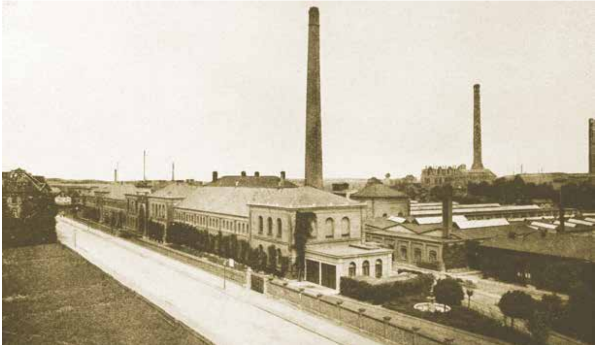
Abb. 11: Die Jutefabrik im Eichthal , 1919
