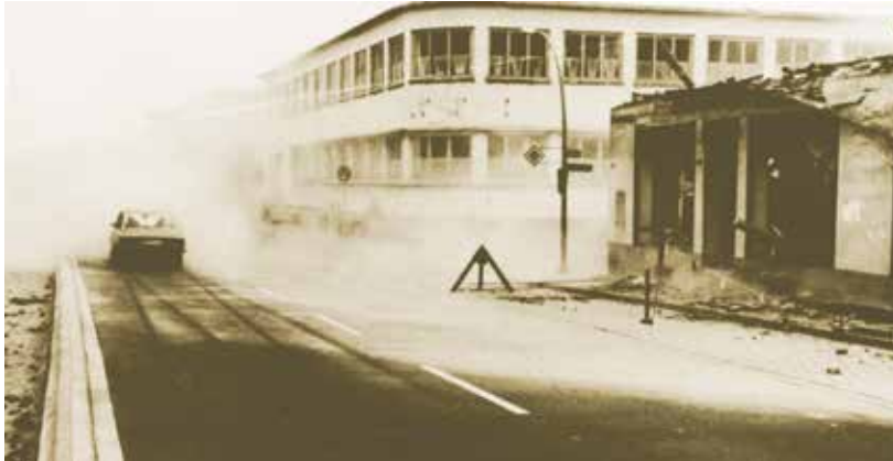
Abb. 103: Verwaltungsgebäude Frankfurter Str. / Kramerstr., 1979
