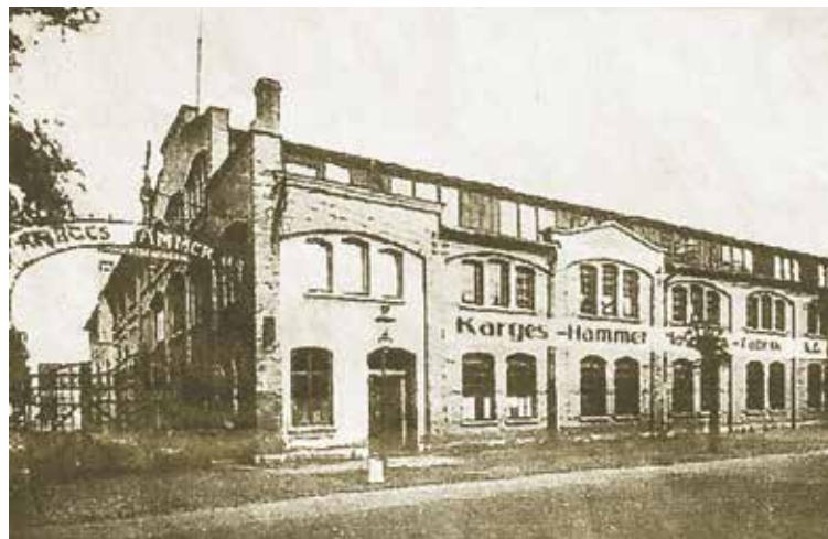
Abb. 155: Das alte Fabrikgebäude
