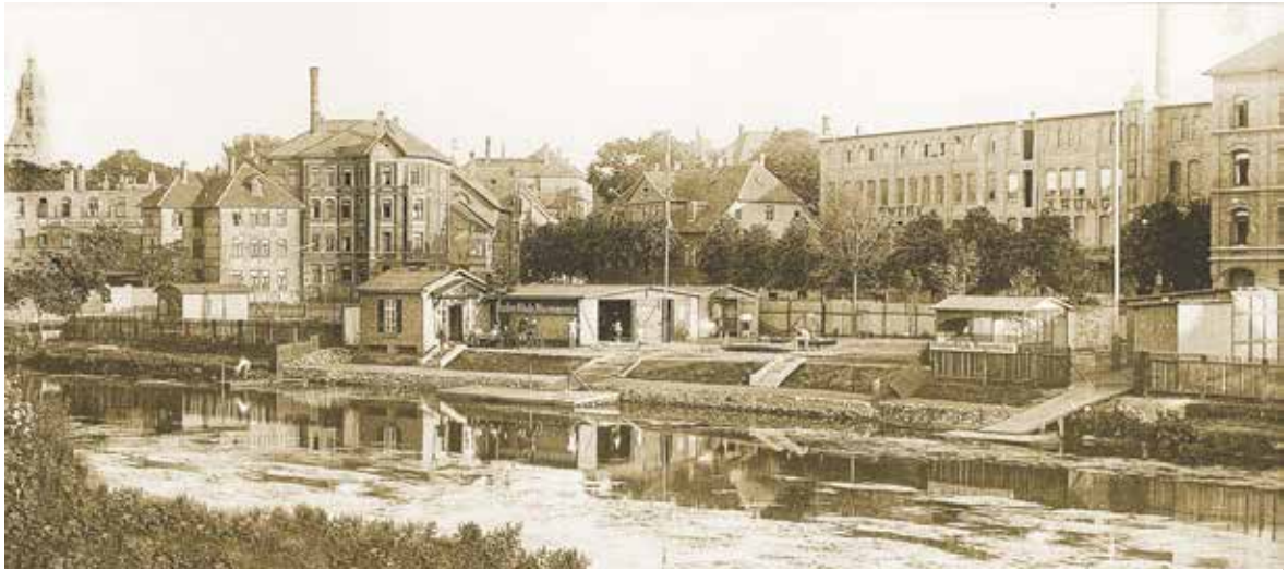
Abb.15: Die Blechwarenfabrik A. Runge (rechts), 1921
