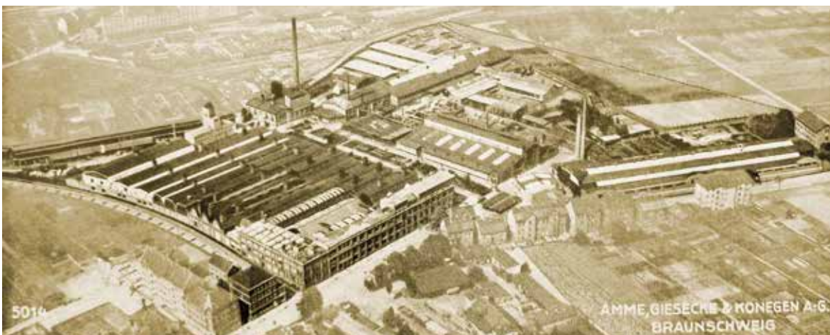
Abb. 3: Luftaufnahme der Amme, Giesecke, Konegen A G in der damaligen Rosstraße, 1920er Jahre
