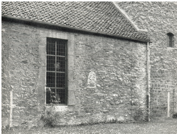
Die weißen Striche am Kirchenschiff und am Turm markieren die Fundamente der steinernen Kapelle; Foto: Dr. Bornstedt
