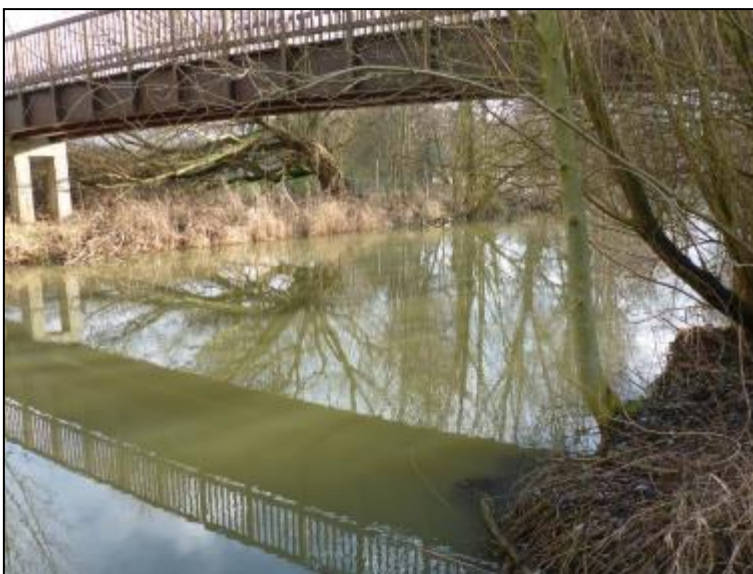
Abbildung 31: Fließgewässerabschnitt S 5 B
