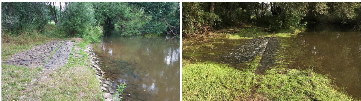
Abbildung 3-11: HWE am linken Schunterufer bei MQ und Hochwasserabfluss
