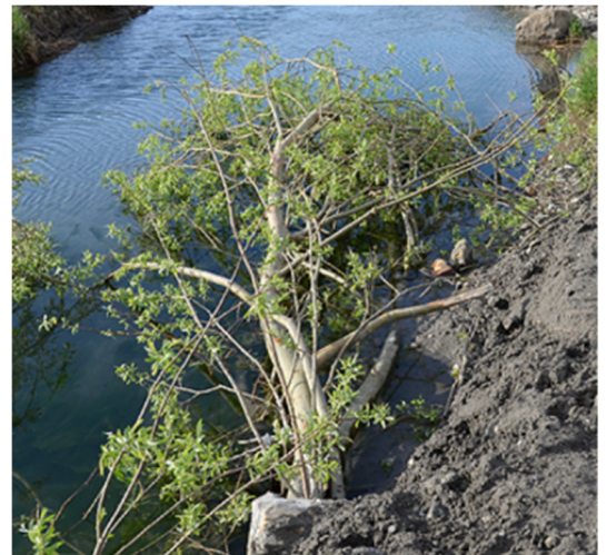
Abbildung 6-13: Raubbaum nach Einbau
