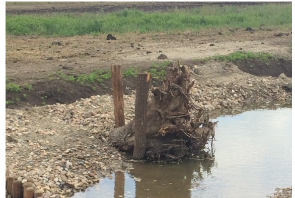
Abbildung 6-12: Wurzelstube nach Einbau
