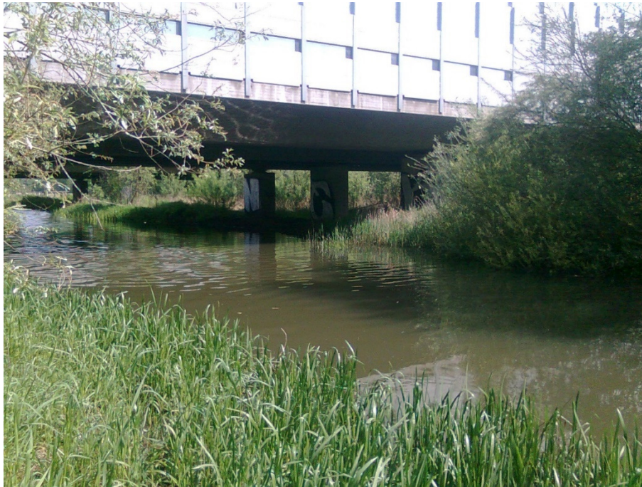
Abbildung 3-10: Brücken der BAB 2 in Fließrichtung
