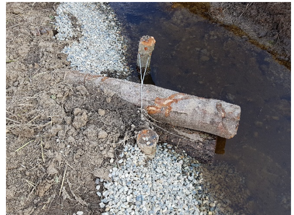
Abbildung 6-9: Beispiel einer Totholzbuhe
