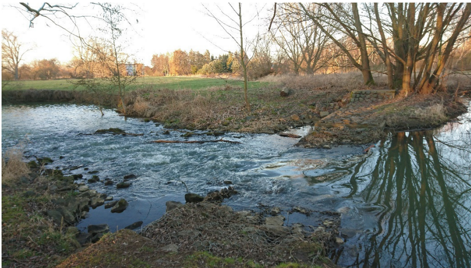
Abbildung 3-12: Wehr Bienrode an km 8+447, Blick Richtung Unterwasser
