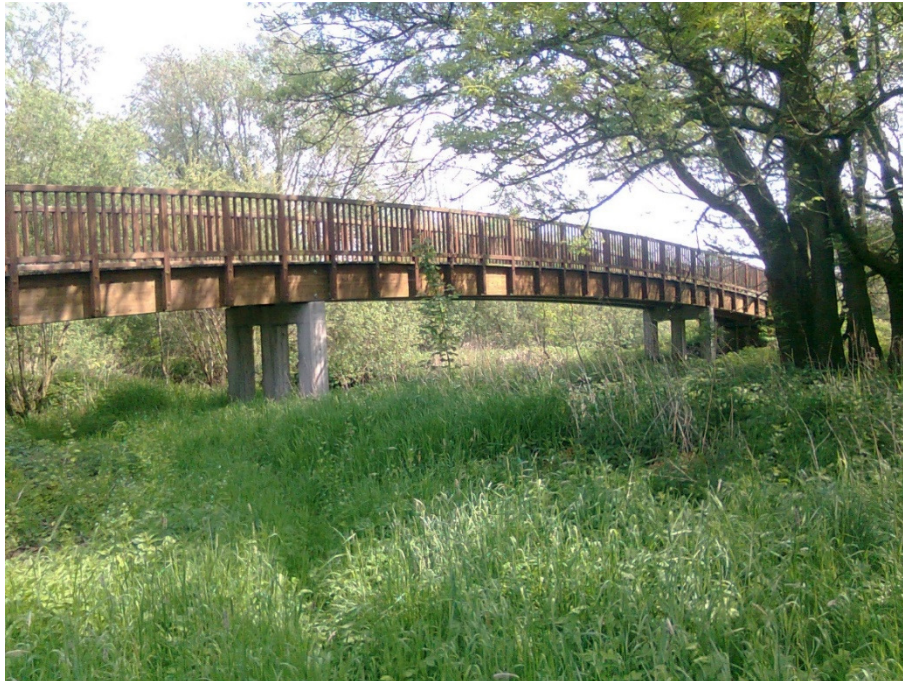
Abbildung 3-8: Fußgängerbrücke südlich der BAB 2
