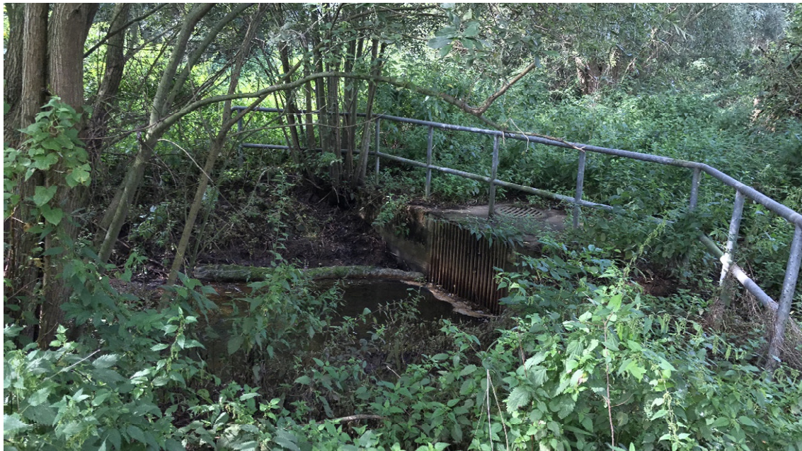
Abbildung 3-9: Auslaufbauwerk Düker am linken Ufer der Schunter
