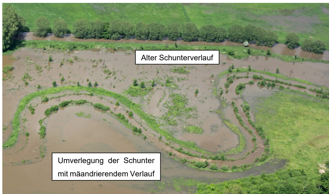
Abbildung 6-5: Beispiel an der Schunter bei Harxbüttel, hier renaturierter Abschnitt bei einem Hochwasserereignis [5]
