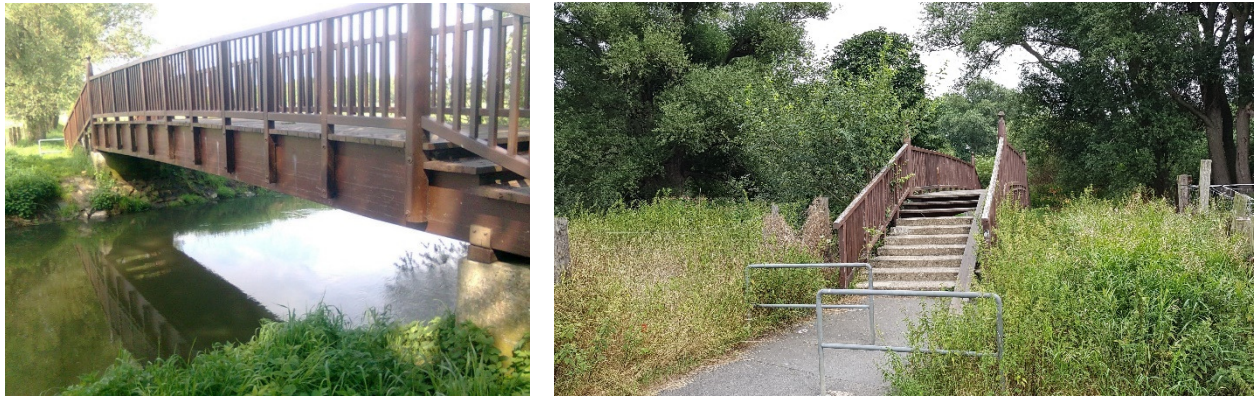
Abbildung 3-6: Fußgängerbrücke Im Alten Dorfe
