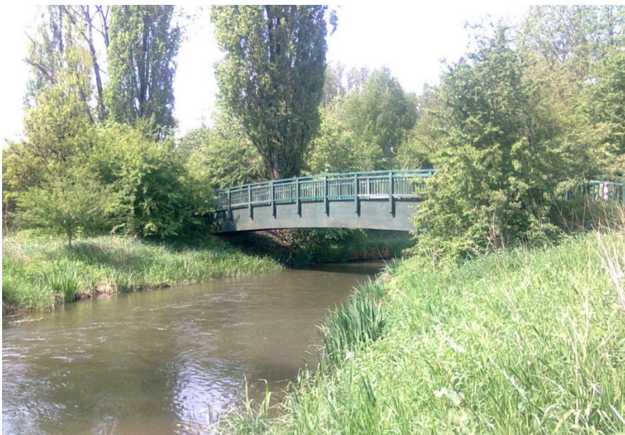
Abbildung 3-13: Brücke unterhalb des Wehres
