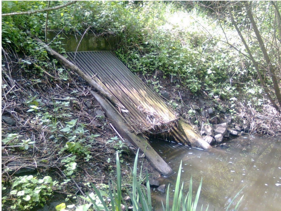
Abbildung 3-15: Auslauf des Ohe-Durchlasses unter der BAB 2 in den Schunteraltarm
