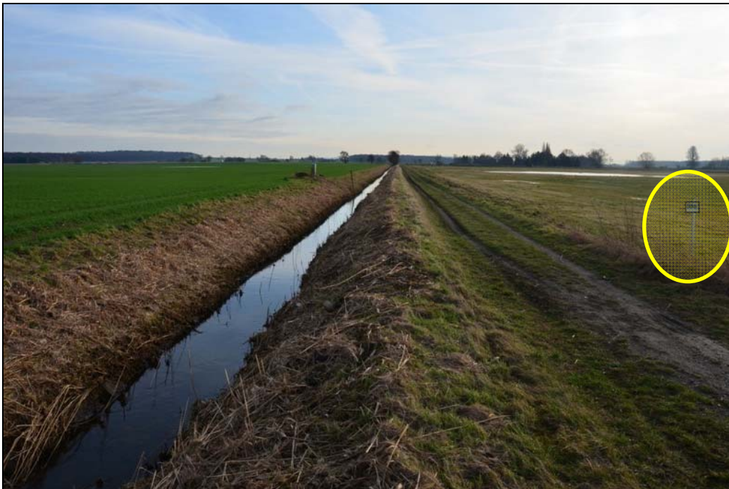
Abb. 13: Düker unter Reitlingsgraben
