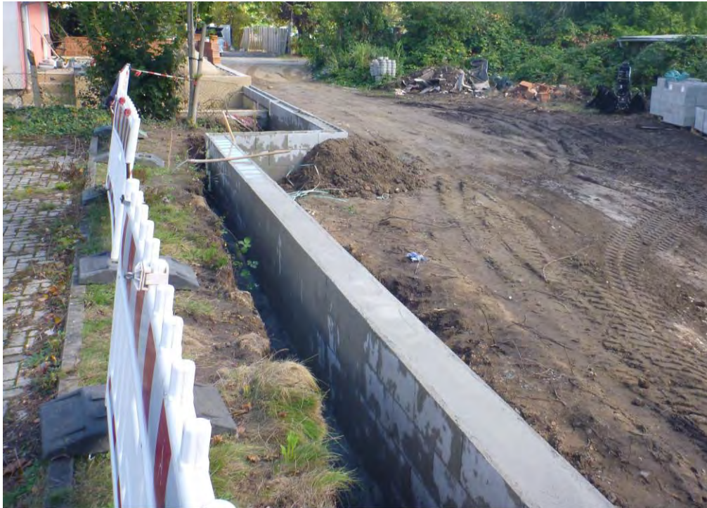
Abbildung 4-10: Bau der Hochwasserschutzmauer Am Soolanger
